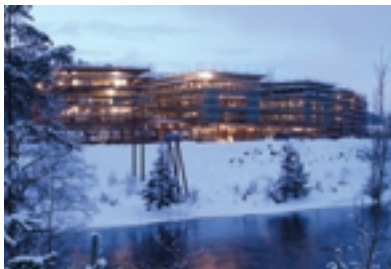
Nybygget med ca 550 nye arbeidsplasser, skal stå ferdig for Kongsberg Simrad høsten 2001
